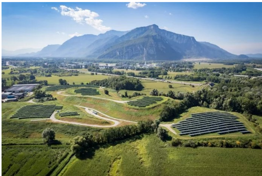
Centrale photovoltaïque la Buisse (ancienne décharge)
